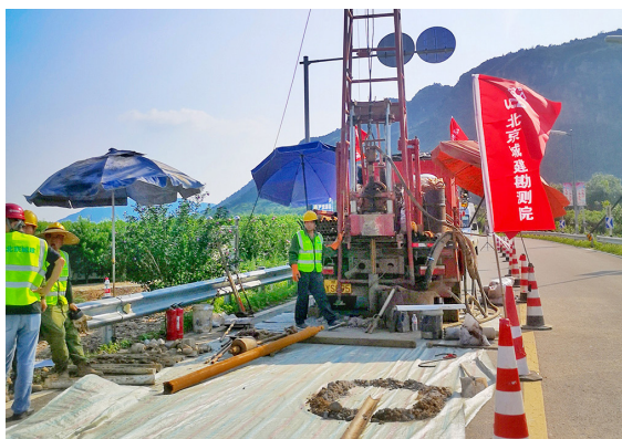
密雲區搶險團隊作業現場
