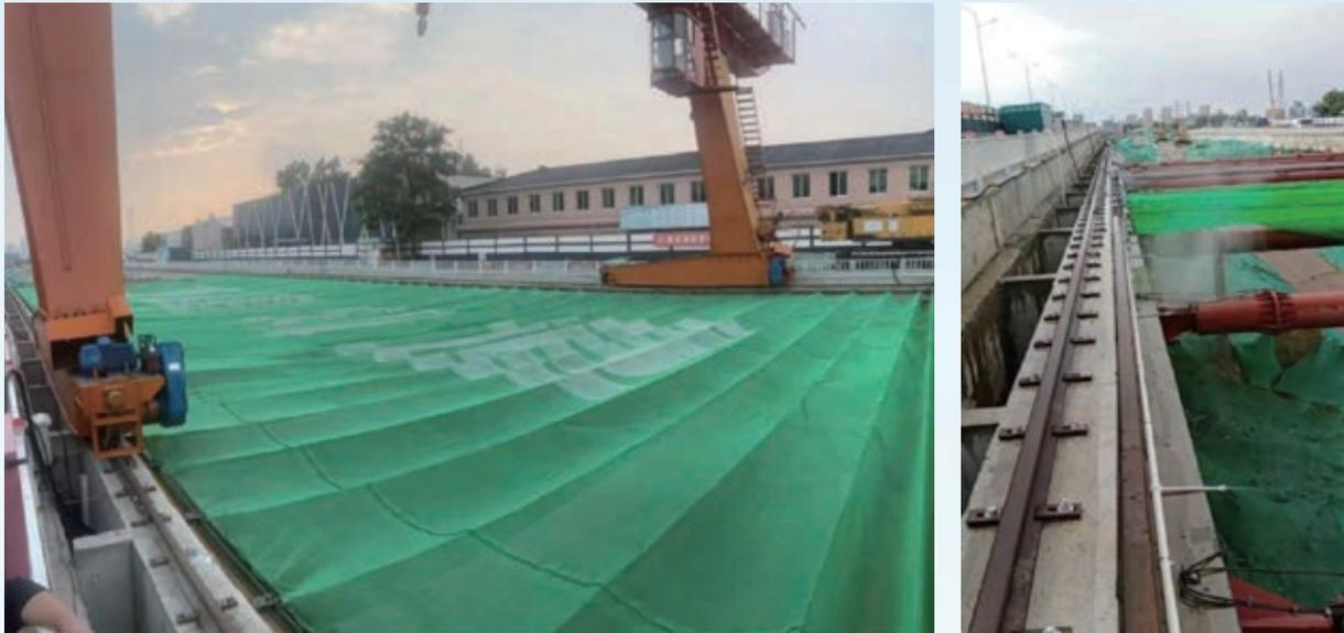
圖：多功能多領域電動天幕（左） 基坑環場自動噴淋系統（右）
